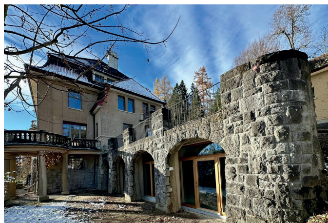
Der neue Seminarraum hinter der Stützmauer. Hierfür wurden die bereits vorgezeichneten, aber noch mit Stampfbeton gefüllten Bogenfelder geöffnet.
